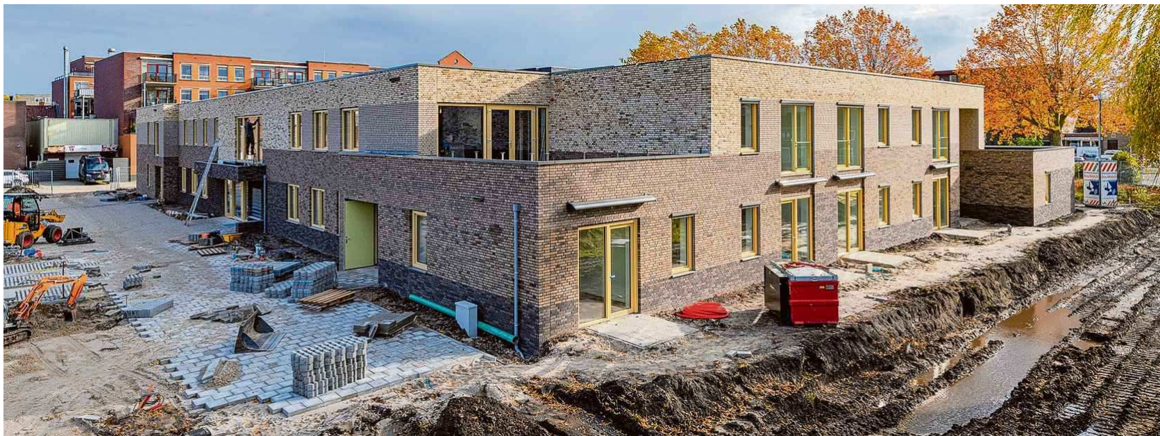
Het gisteren opgeleverde woonzorgcomplex aan de Brederoweg in Hogeveen. De bouw is goeddeels gereed; nu is het tijd voor de inrichting van de appartementen en het terrein rondom. FOTO WALTER FRISART
